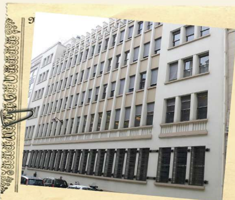
Immeuble Rocher, façade rue de Vienne
