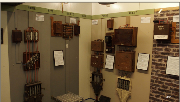
Fin des travaux d'aménagement de l'espace « colonnes montantes » (1er étage)
