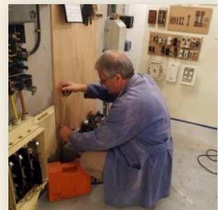
Tx de finitions sur colonnes montantes
