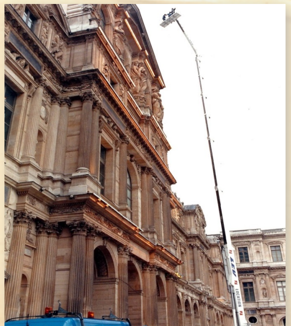
... et sa mise en oeuvre.
