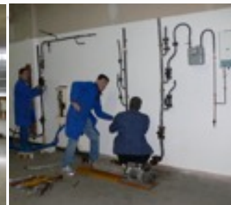
D'anciennes conduites montantes ... newes!
